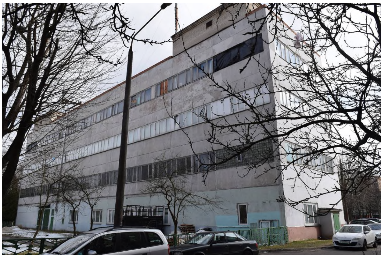
Фото А.2 – Общий вид здания в осях «11 – 1», «В – А»
