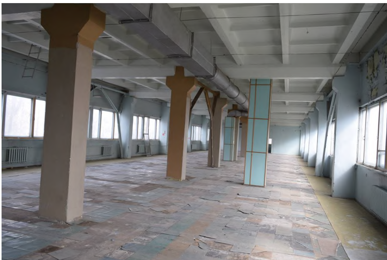
Фото А.4 – Общий вид помещения в осях «А – В», «3 – 10» внутри здания
