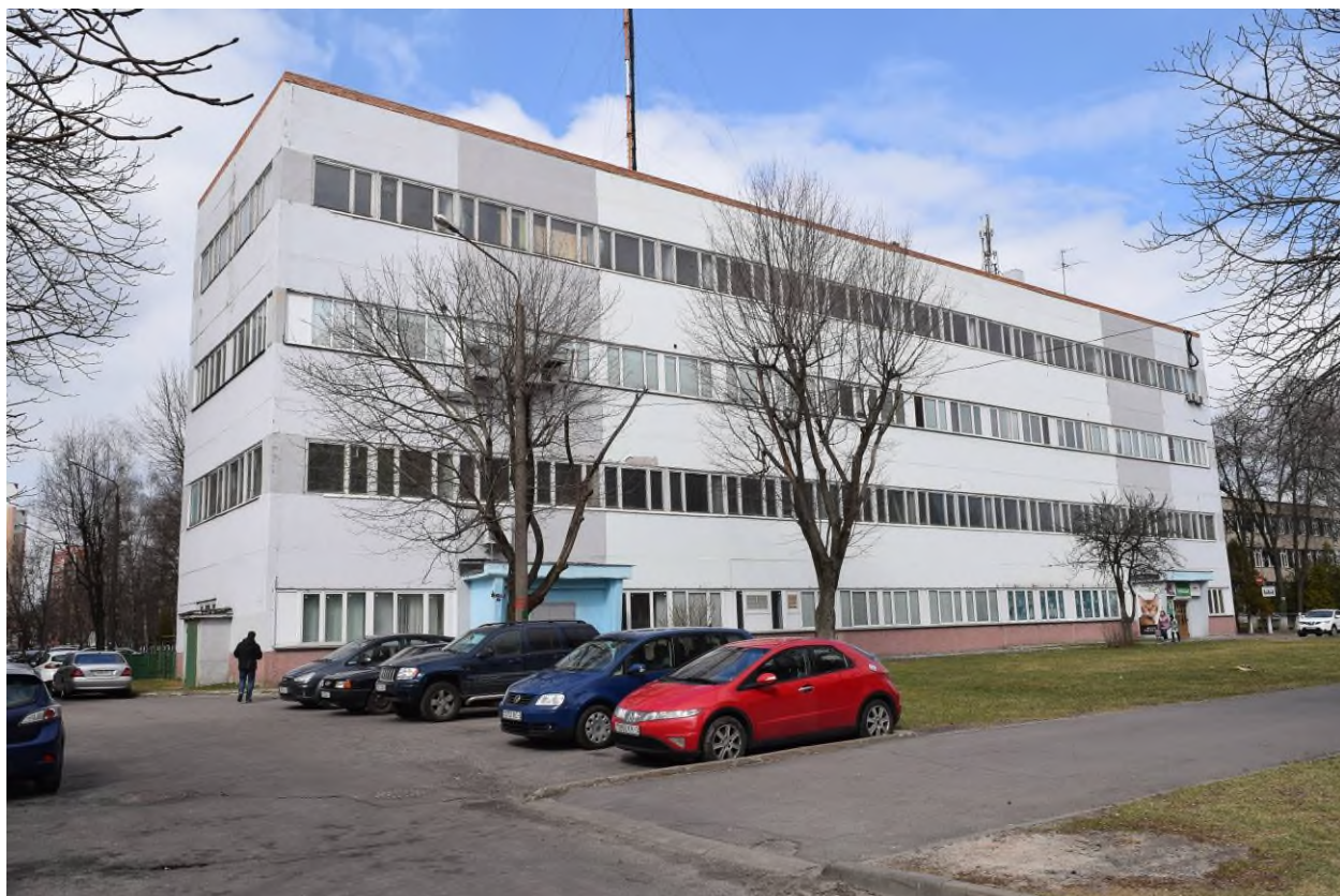
Фото А.1 – Общий вид здания в осях «В – А», «1 – 11»
